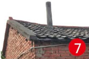
石綿水泥煙囪
