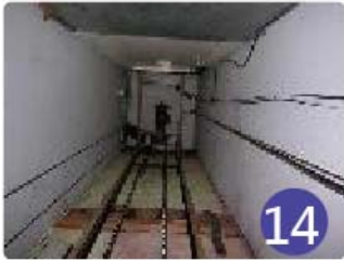
電梯井道牆面(文獻 14)
