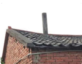
含石綿成份煙囪
