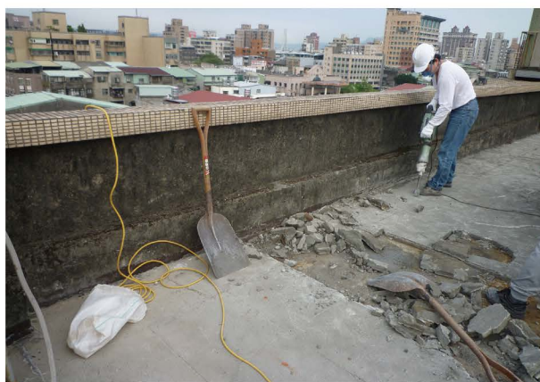
原有頂樓防水層拆除。
