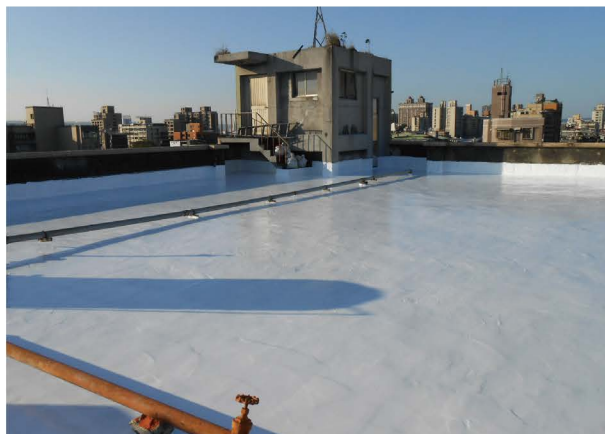
頂樓防水面塗施工。
